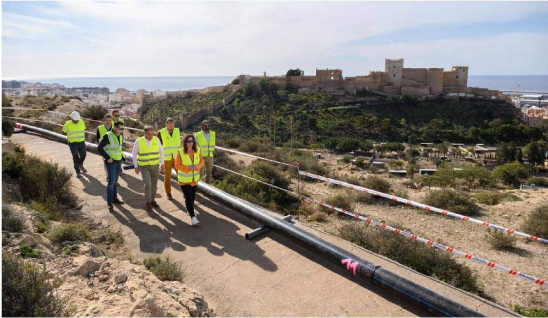
Visita de la alcaldesa a las obras de la tubería que conecta desde San Cristóbal
